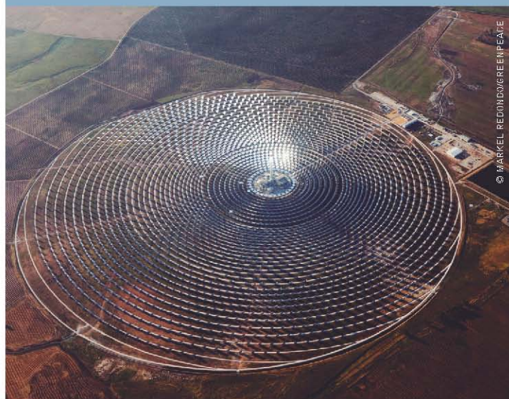
[imagen] CENTRAL TERMOSOLAR DE TORRE CENTRAL GEMASOLAR (SEVILLA), PROPIEDAD DE TORRESOL ENERGY, CON UNA POTENCIA DE 15 MW. SU SISTEMA DE ALMACENAMIENTO DE 16 HORAS EN SALES FUNDIDAS PERMITE SUMINISTRAR ENERGÍA DURANTE LAS 24 HORAS DEL DÍA.
